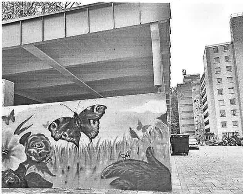
In dem Wohnkomplex An der Ziegelei hat der Spar- und Bauverein Leichlingen die Mülltonnen überdacht, die Fassaden verschönert und neues Pflaster gelegt. FOTO: UWE MISERIUS
